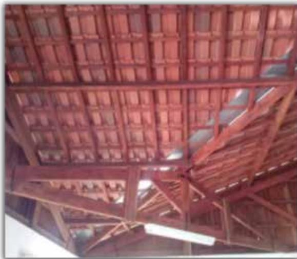
*Teto sem forro: desconforto térmico, sujeira, fuligem de cana de açúcar (MONTEIRO, 2014).*
